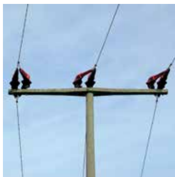
2 Hauben in paralleler Anordnung bei „doppelter Sicherheit“
