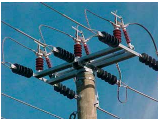
Leitungstützisolator in Verbundbauweise
