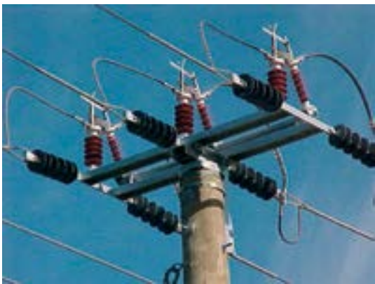
Leitungsstützisolator in Verbundbauweise
