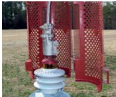
BCAC-IC mit geöffnetem Käfig(Gehäuse) während der Montage
