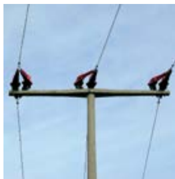
2 Hauben in paralleler Anordnung bei „doppelter Sicherheit“
