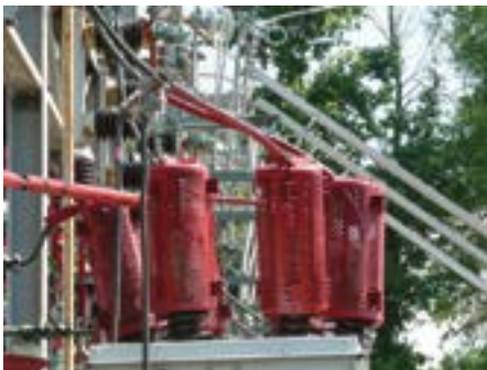
BCAC-IC mit geschlossenem Käfig (Gehäuse)
