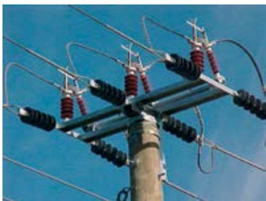
Leitungstützisolator in Verbundbauweise
