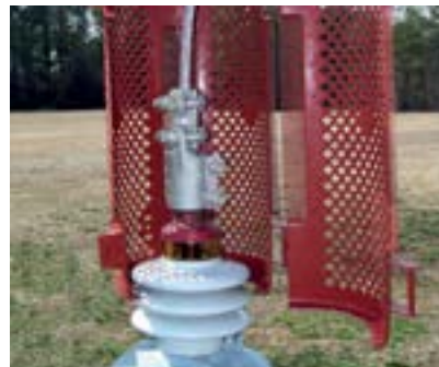
BCAC-IC mit geöffnetem Käfig(Gehäuse) während der Montage
