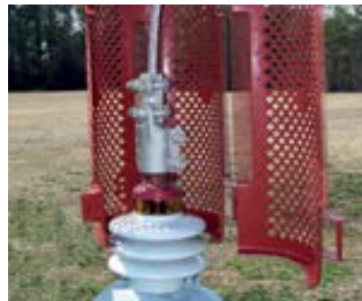
BCAC-IC mit geöffnetem Käfig(Gehäuse) während der Montage
