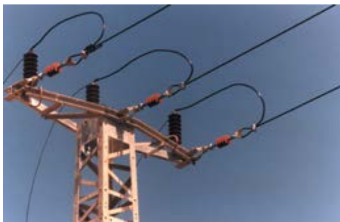
Zugisolator in Verbundbauweise
