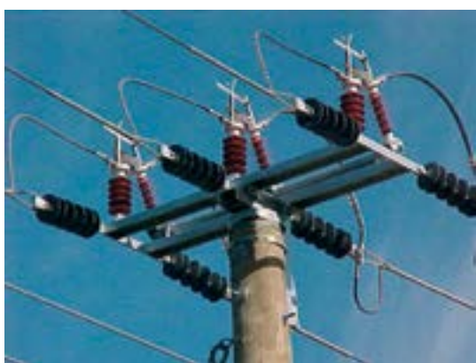
Leitungstützisolator in Verbundbauweise
