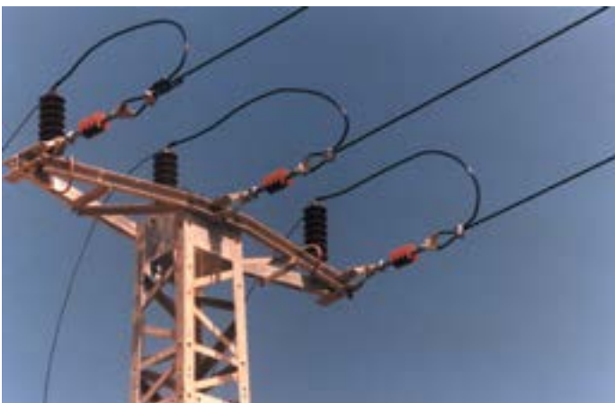
Zugisolator in Verbundbauweise
