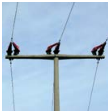
2 Hauben in paralleler Anordnung bei „doppelter Sicherheit“
