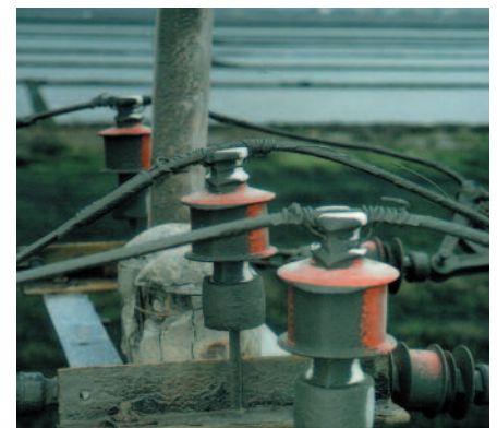
Hybrid-Isolatoren (Raybowl) bei extremer Verschmutzung
